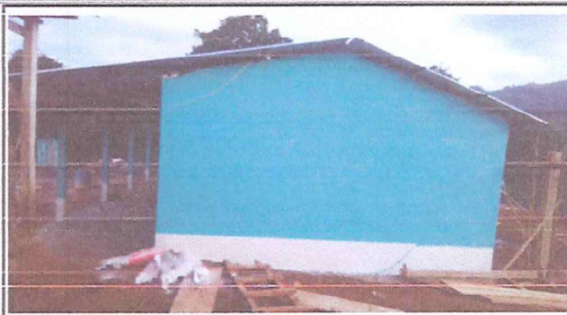
Foto 2: pintura de aula remozada
