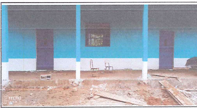
Foto 6: Terminacion de pintura
